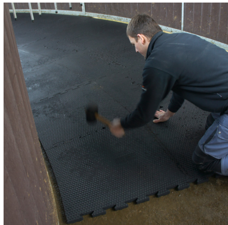
Einbau Führanlage-Belag
