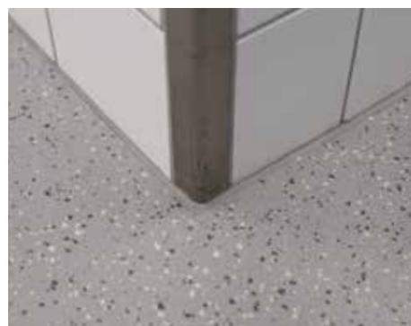
Urin- und wasserdichte Fugen
